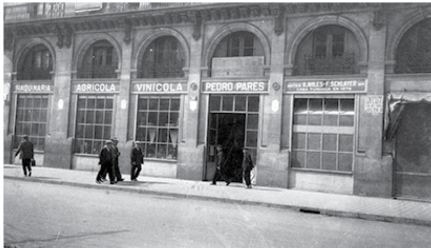
Two views of the Pedro Parés premises at 15-17 Avenida del Marquès de l'Argentera, Barcelona.
