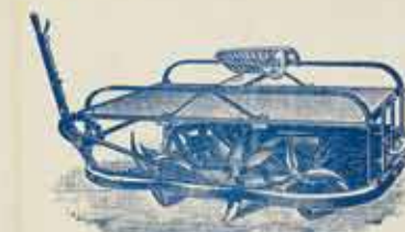
Fig. 2112 - Cuerpo de grada de paletas de 0,70 m. ancho de trabajo. (Se pueden suministrar varios cuerpos según la anchura deseada).
